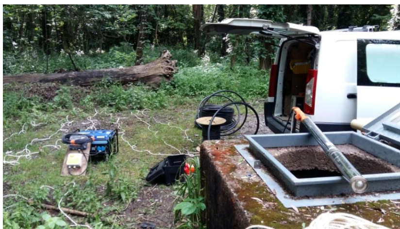
Figure 107 : Installation de la pompe immergée dans le forage F1 de Gerbial pour des prélèvements ponctuels d'eau au fond de l'ouvrage
