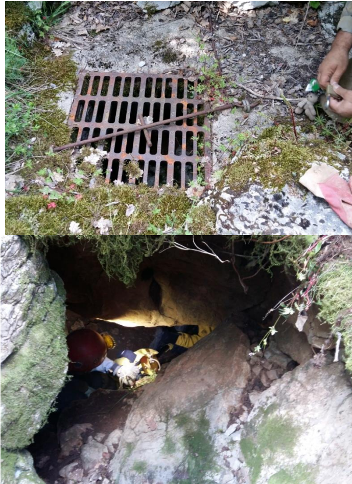
Figure 105 : Mise en place du fluorimètre dans le réseau Douce Paulette par les spéléologues (à gauche) et grille cadenassée fermant l'accès au réseau (à droite).
