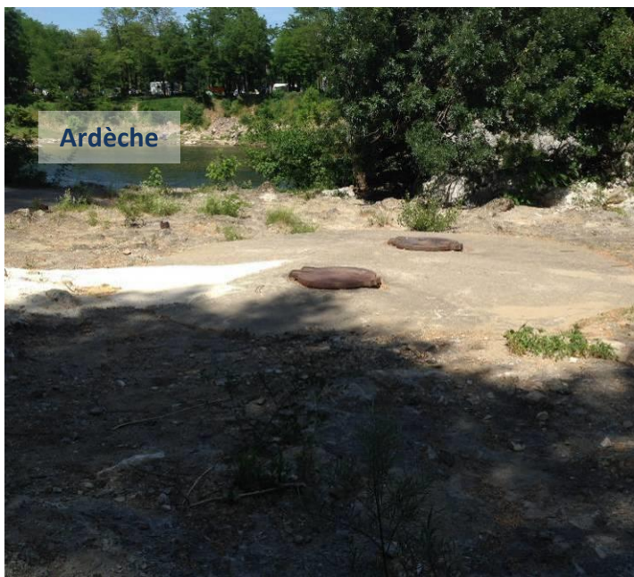
Figure 78 : Photographie du captage du Bœuf (forages F1 et F2) prise en rive droite de l'Ardèche
