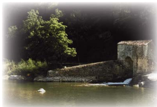
Prise d'eau et canal d'irrigation de Baza
