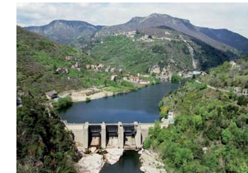
Barrage de Pied-de Borne sur le Chassezac
